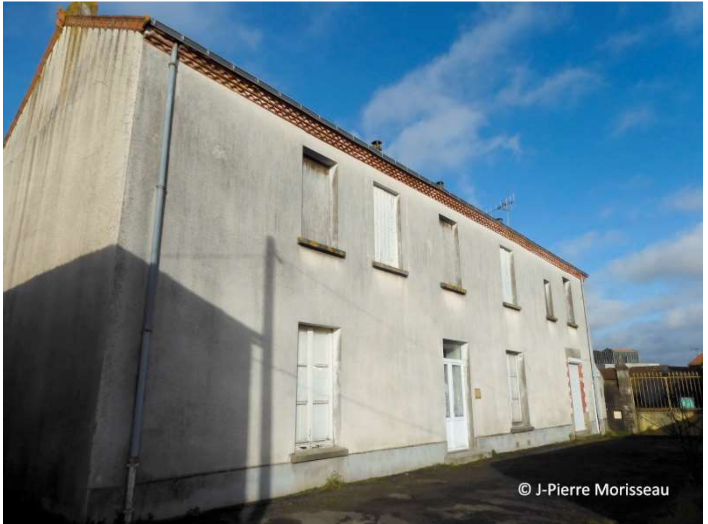
Le bâtiment de la cure : les bureaux au rez-de-chaussée, les chambres à l'étage
