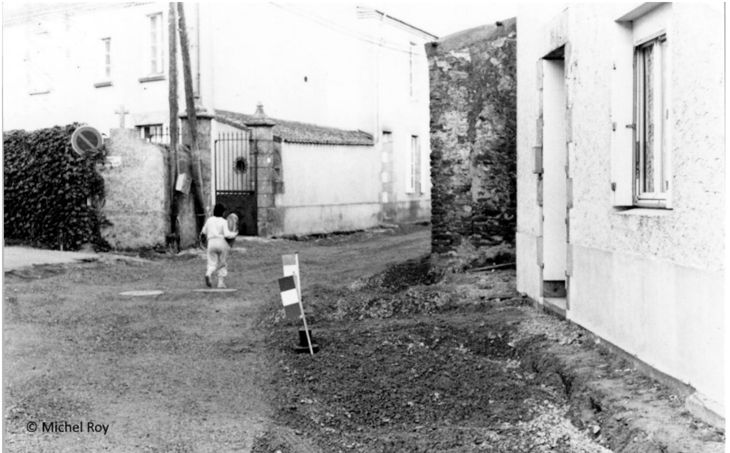
La Rue Saint-Philbert en rénovation pendant les années 1980 à proximité de la cure
