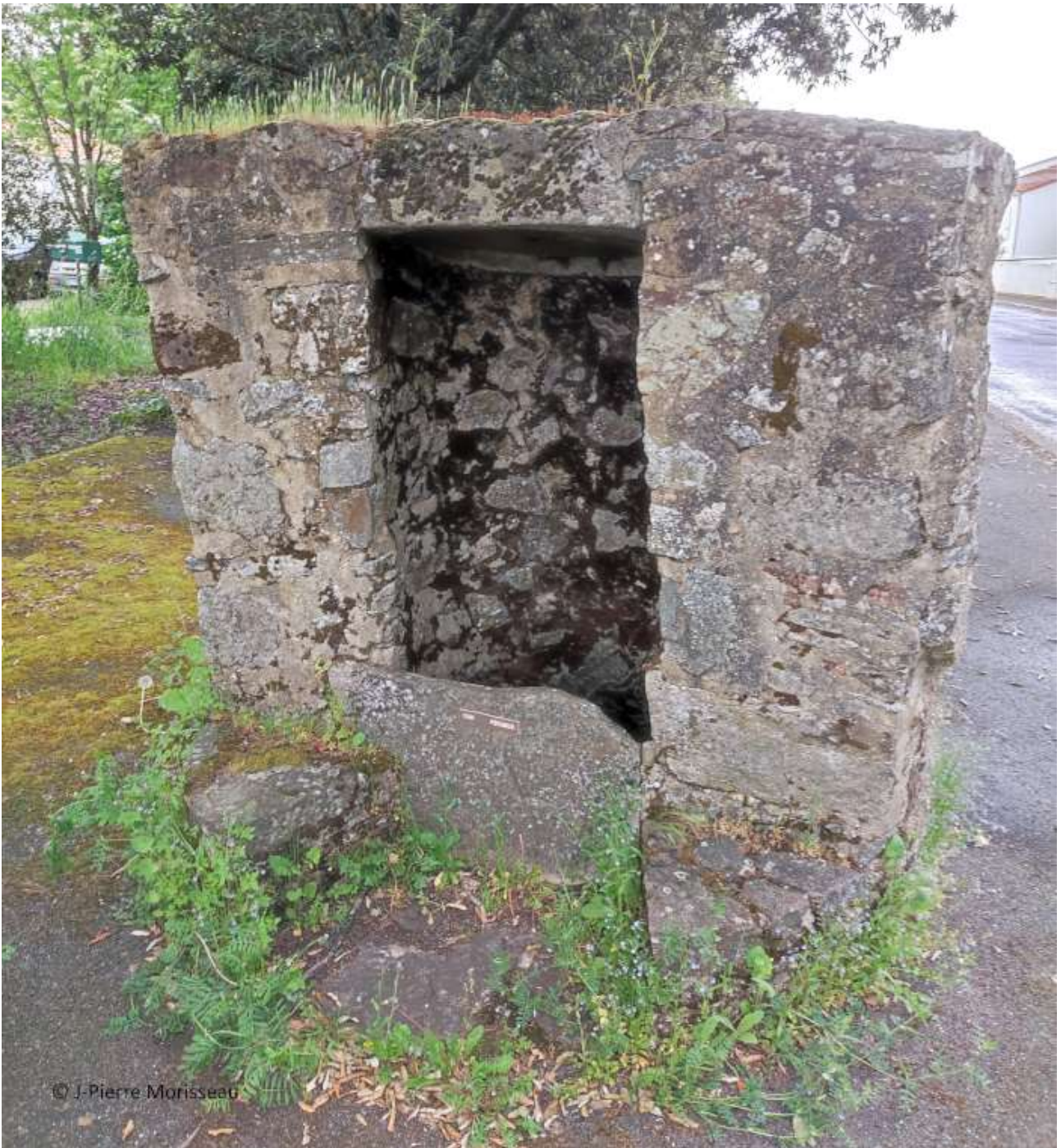
Le puits du Haut-Beauvais
