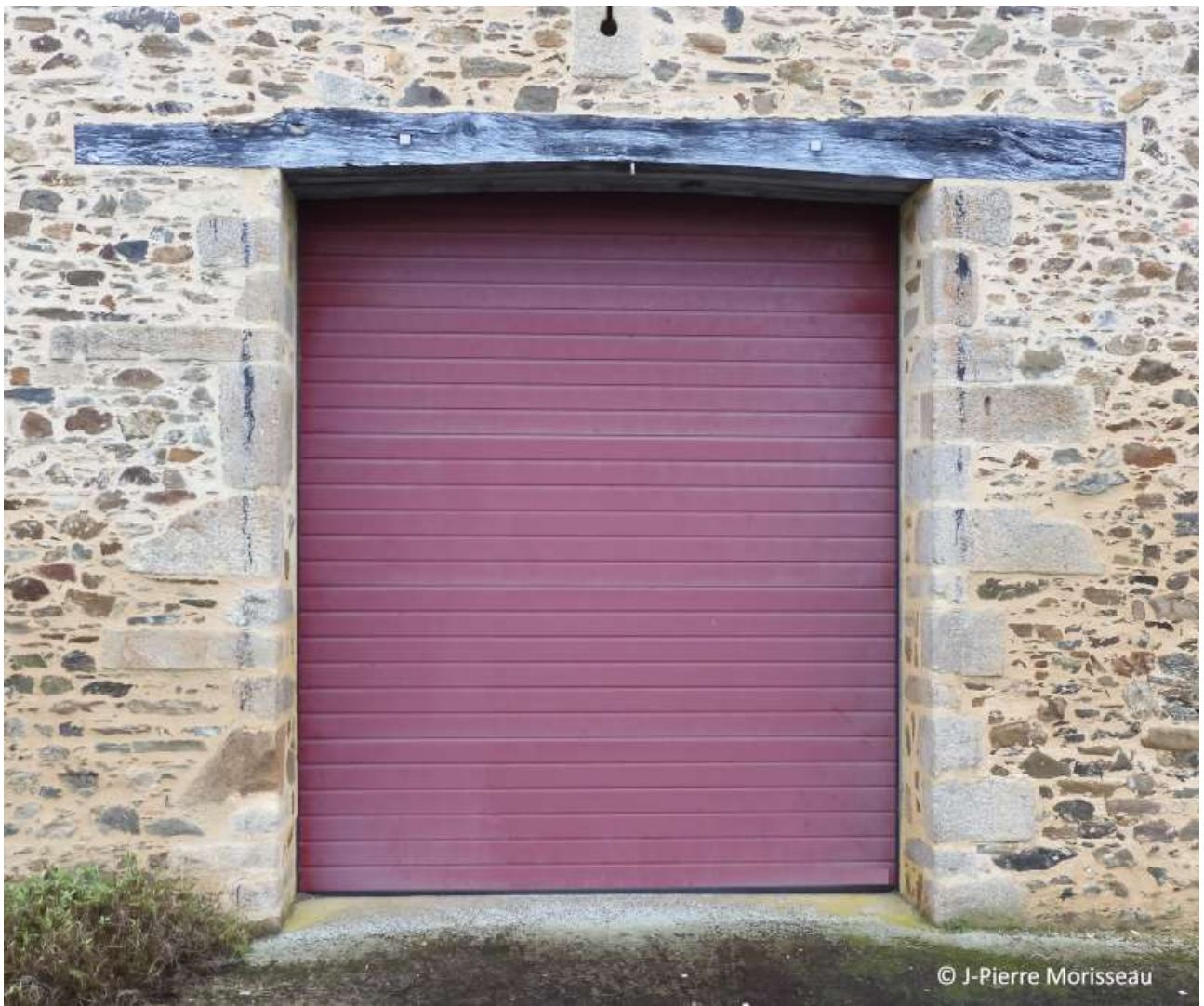
Le portail principal de la grange
