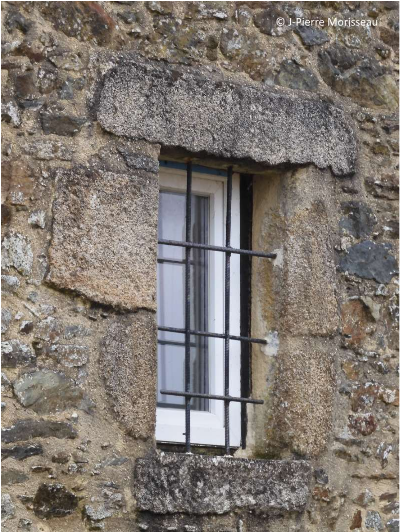
Ouverture consolidée par des blocs de granit
