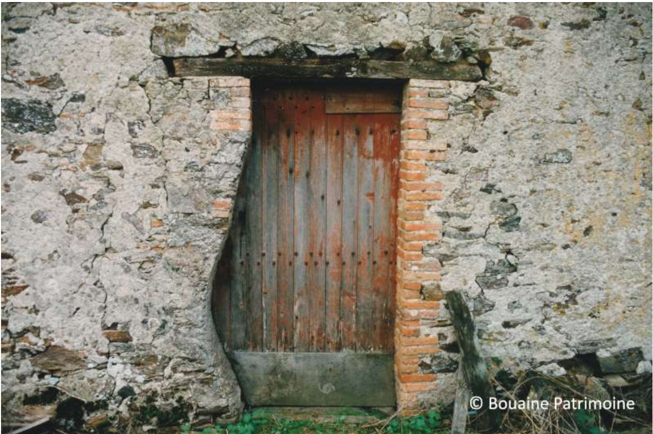
La porte de la cave a été modifiée pour le passage des barriques
